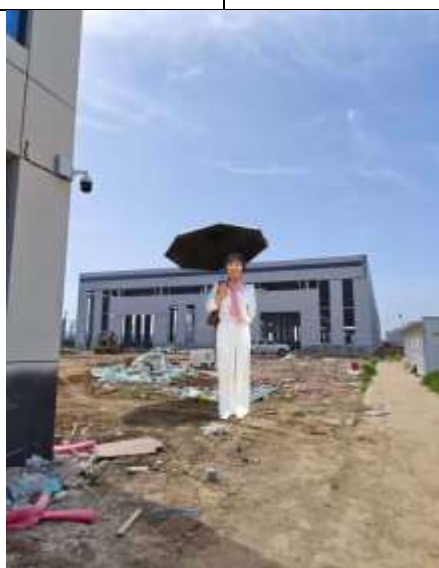
工程师现场勘查照片
